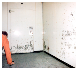
Fig. 1: Vægge med ståloverflade. - Før renovering med Glasbord® paneler
