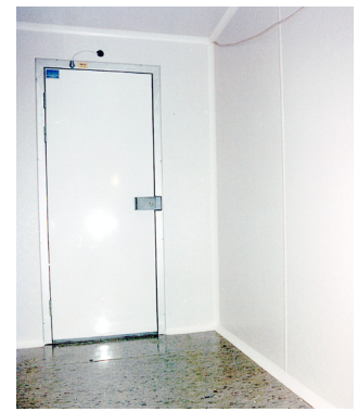
Fig. 2: Efter renovering med Glasbord® paneler
